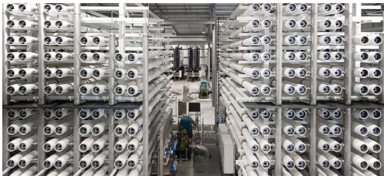
DESALINIZACIÓN. Acciona inauguró en 2010 la primera planta de desalinización en Londres (en Beckton), impulsada por el crecimiento de la población, así como por la escasez de recursos naturales en la zona. Es la primera planta desalinizadora que extrae agua del estuario del Támesis usando la técnica de membranas de ósmosis inversa. Fue galardonado en 2009 como el proyecto más sostenible del año por la revista 'Global Water Intelligence' y en el 2011 como Mejor Planta Desaladora. / ACCIONA
