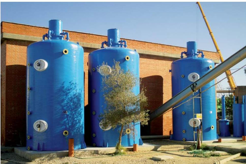
Fig. 6. Reactores UASB prototipo
